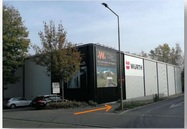
Die Zufahrt ist nur von dieser Seite her erlaubt. Hier finden Sie den Eingang Süd (Treppenhaus).
